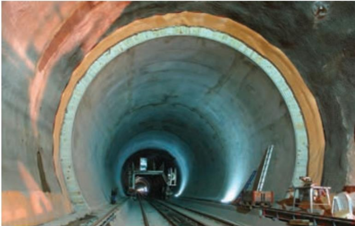
شکل ۴-۶- پوشش داخلی تونل به وسیله قطعات بتن
