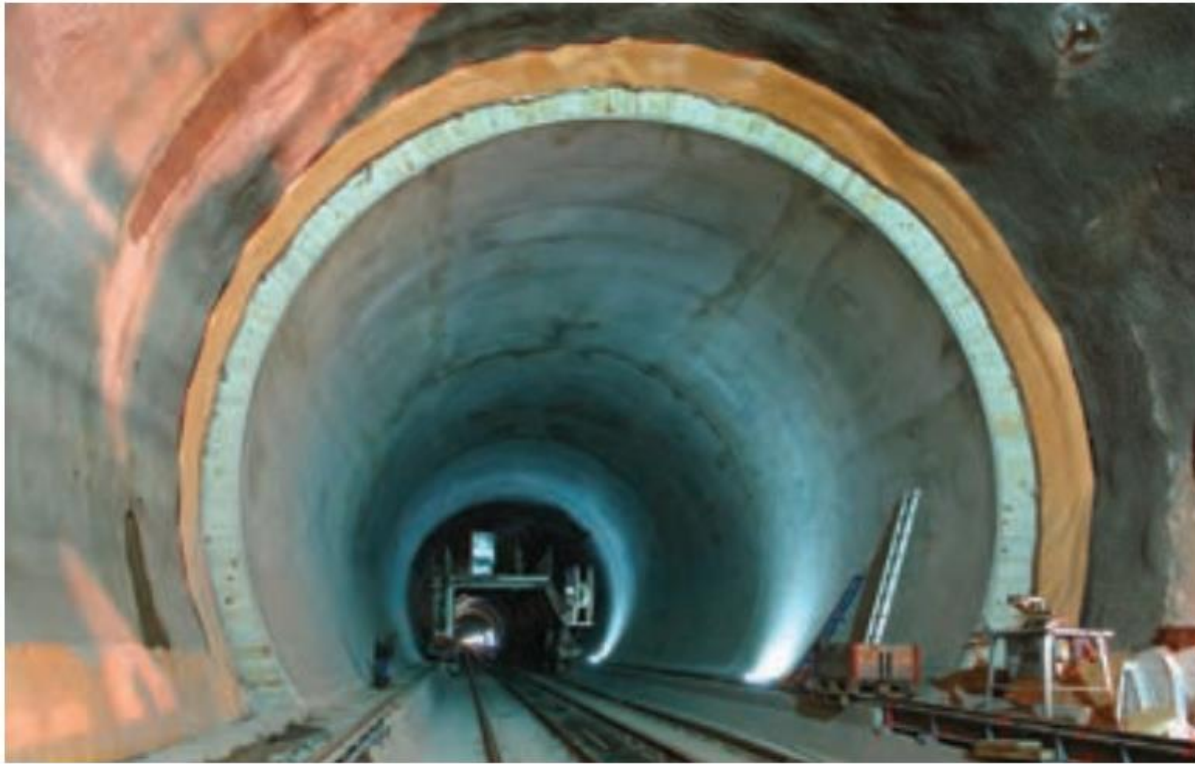
شکل ۴-۶- پوشش داخلی تونل به وسیله قطعات بتن
