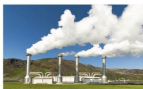
نیروگاه زمین‌گرمایی مشکین‌شهر، اردبیل
