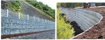
دیوار حائل گابیونی (تورسنگی)
